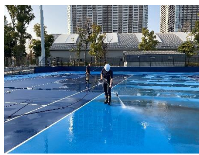
屋外コート洗浄作業
