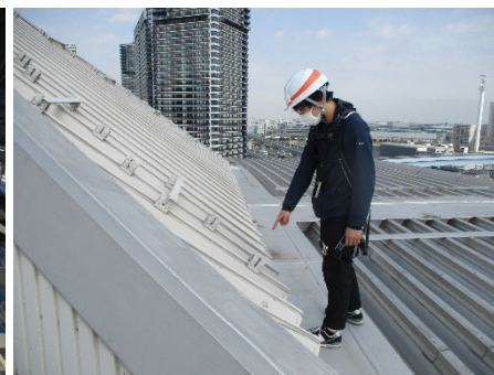
コロシアム屋根点検
