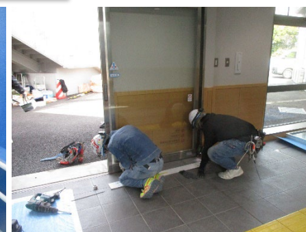
自動ドア防護柵設置
