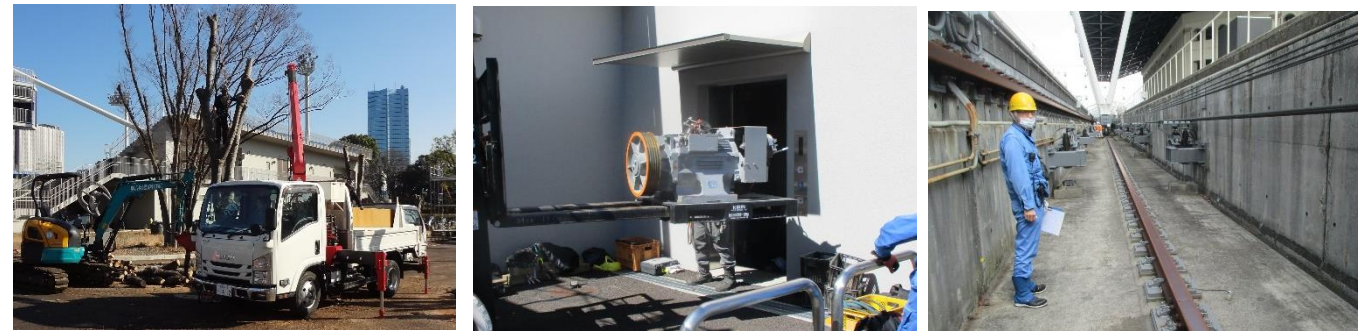
枯損木の撤去
