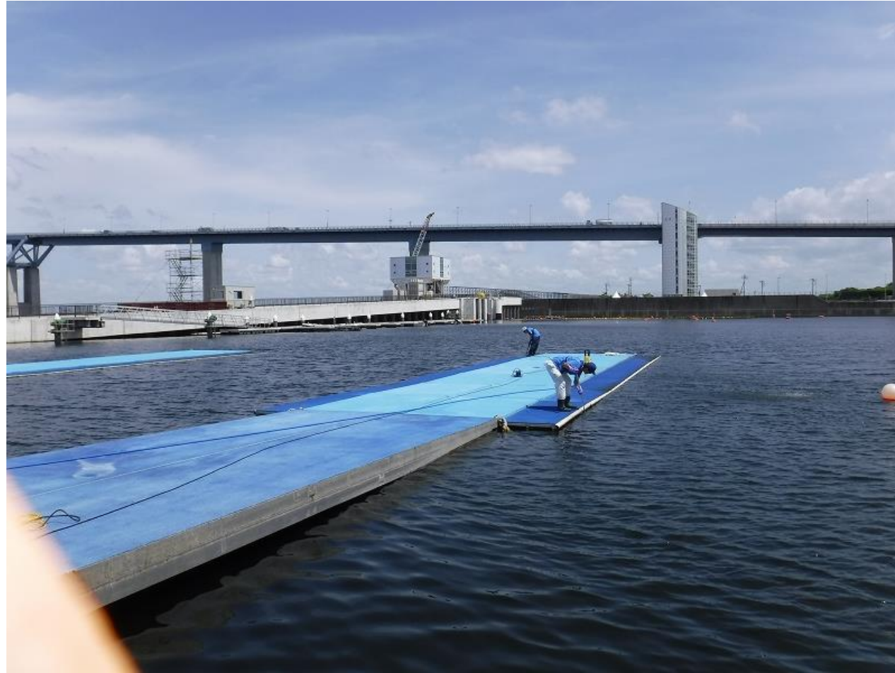
ポンツーンの縁に付着したカキガラ等の清掃
