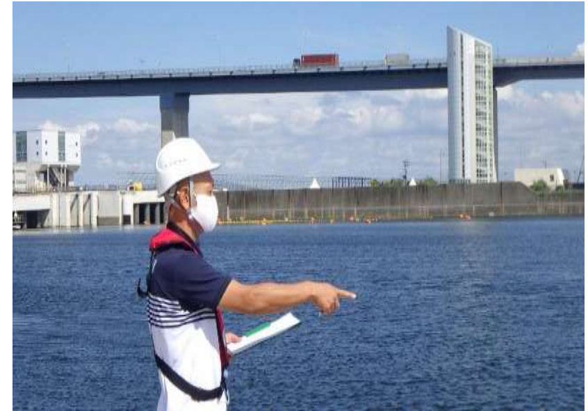
施設巡回点検（毎日）
