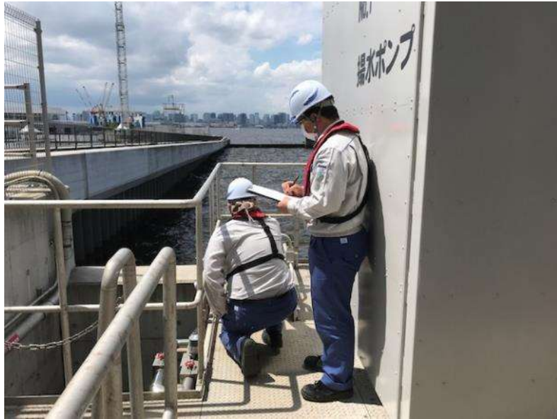
揚排水ポンプ定期点検
