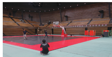
パネル式の素材を組み合わせ、床全体を覆うスポーツコートを導入している施設もあります。 (大田区総合体育館)
