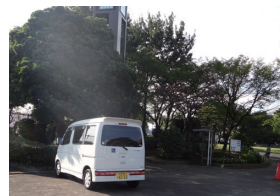
エントランス部分を臨時駐車場に (葛飾区総合スポーツセンター体育館)
