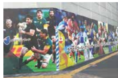
スバルビル解体工事仮囲い
