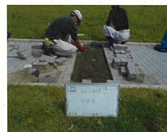
インターロッキング舗装修繕
