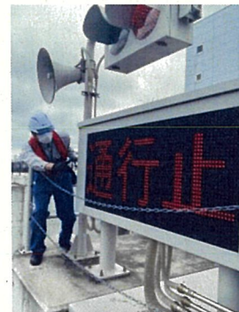
通船警告表示板点検
