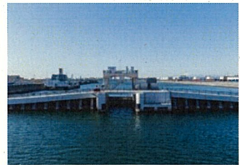
水門(西側)全景
