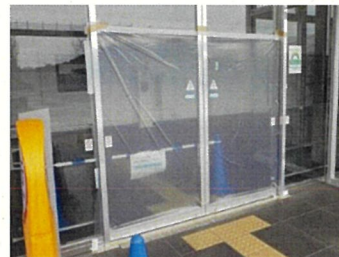
風水害対策 （自動扉の養生）
