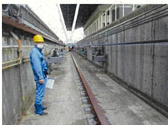
屋根開閉駆動装置の点検
