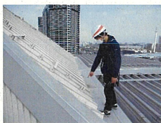
コロシウム屋根部の点検
