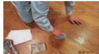
修繕作業の様子(本施設)
