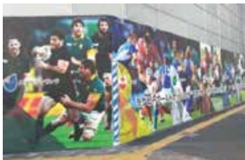
スバルビル解体工事仮囲い (新宿駅西口)
