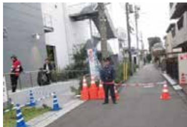
ロードコーンによる進入抑制 (スタジアム付近スポーツショップ前)
