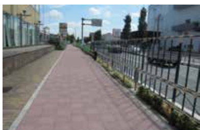
歩道に設置したパイプ柵 (甲州街道)
