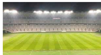
競技用照明のLED化完了後の状況
