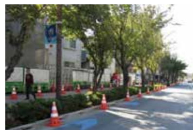
ロードコーン設置状況（飛田給駅付近）
