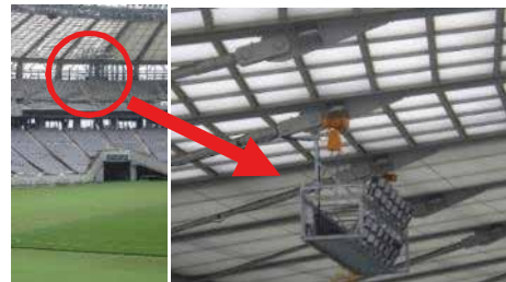
競技用照明（仮設）の設置状況
