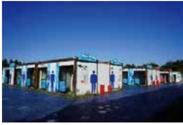
仮設トイレ設置状況
