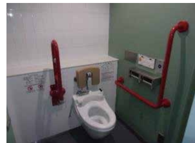
トイレの洋式化完了後の状況
