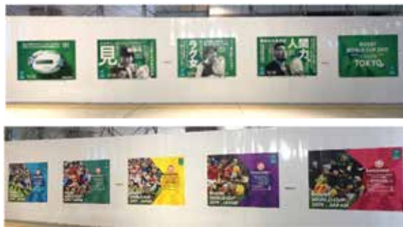
正面入口工事囲い
