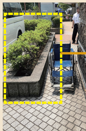
<撤去前> 〔上石神井体育館（練馬区）〕
